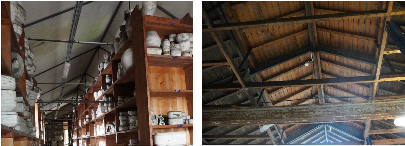
Vue de la charpente métallique de l'aile Nord – Vue de la charpente métallique du bâtiment 12 - 2024
