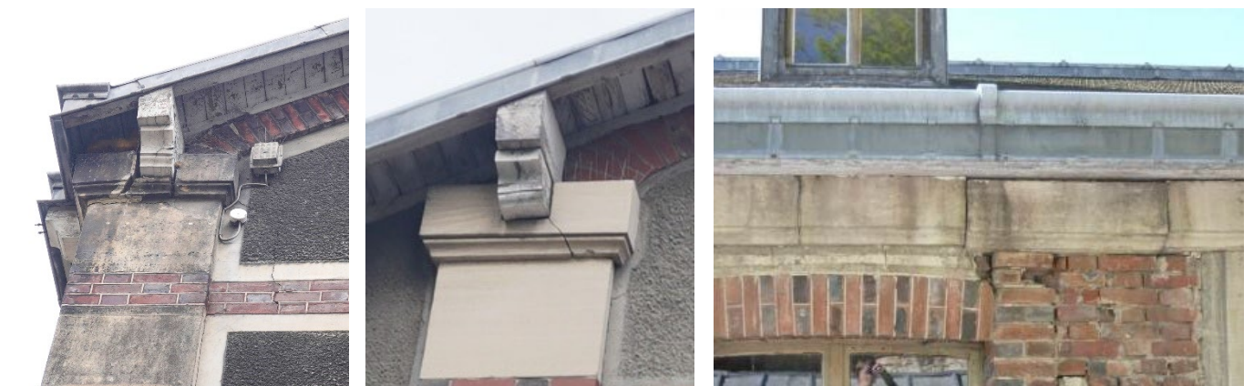
Pierres cassées ou fracturées. Déjointoiment des corniches et désorganisation ponctuelle. Photos : Façade Est de l'aile Sud // Façade Ouest de l'aile Nord // Façade Nord de l'aile Nord.
