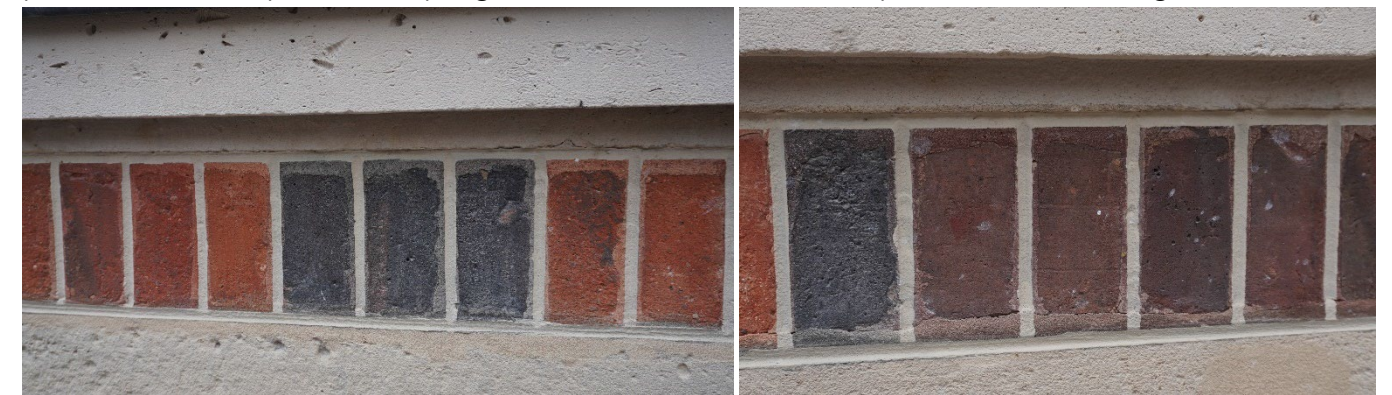
Exemple de badigeon fausse-briques et faux-joint rubans réalisés sur des joints et ragréages ciment du bâtiment 14 (chantier de restauration clos/couvert 2019/2020 sous la direction de MS de Ponthaud, ACMH).
