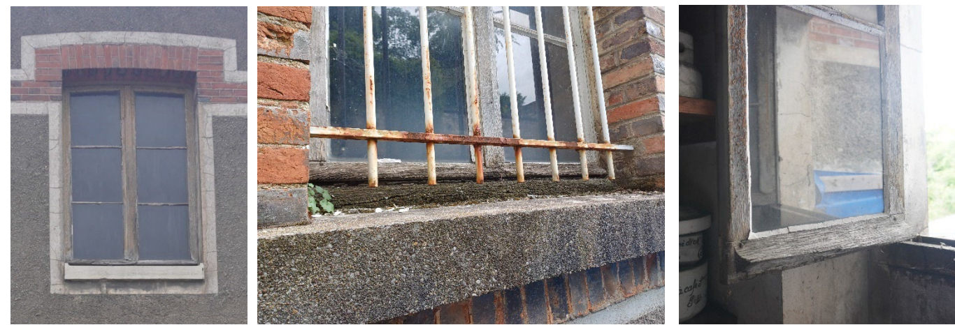
Défaut d'entretien des menuiseries, bois à nu et gercé, appui et jet d'eau pourris. On peut noter l'appui béton d'une des baies Ouest de l'aile centrale. Photos : Façade Est de l'aile Nord // façade Ouest de l'aile centrale // Façade Est de l'aile Nord.
