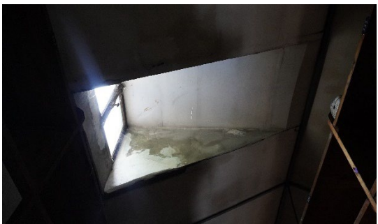
Infiltrations au droit des lucarnes du versant Nord de l'aile Nord.
