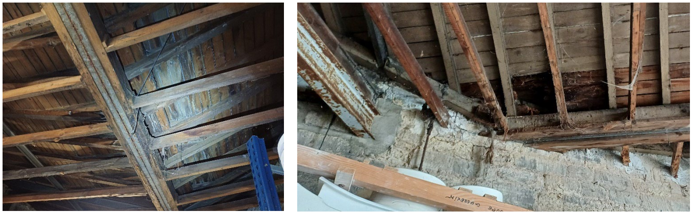
Infiltrations au droit des chéneaux : dégradation du métal, pourrissement des moises sapin. Oxydation des structures métalliques. Photos : Charpente du bâtiment 12.
