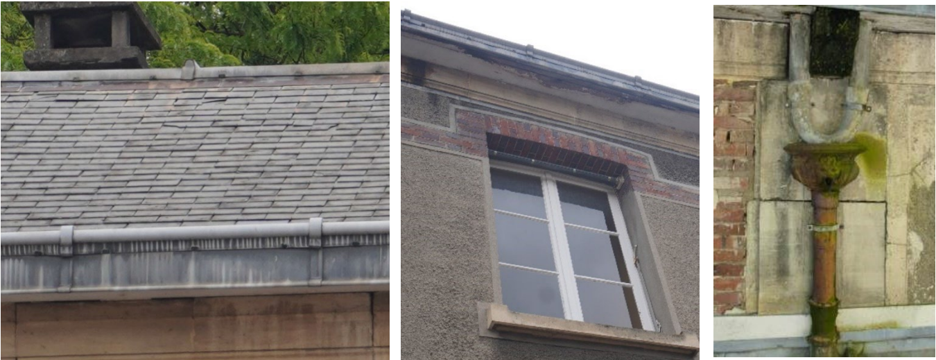
Ardoises cassées ou manquantes, soulèvement. Planche en sous-face d'entablement et corbeau pourris. Oxydation/ corrosion des cuvettes à tête de lion et descentes EP. Photos : Versant Sud de l'aile Sud // Façade Sud de l'aile Sud // Façade Nord de l'aile Nord.
