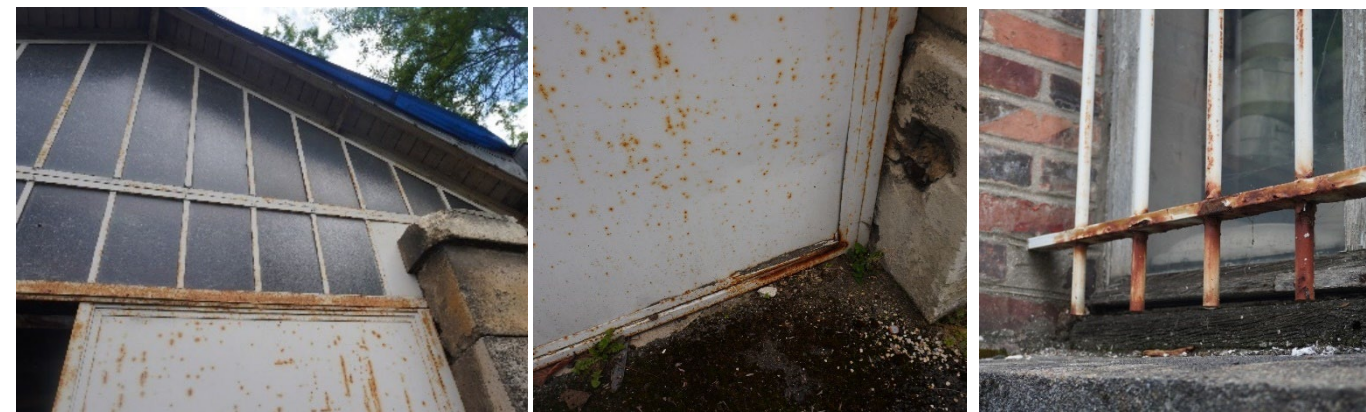
Oxydation/ corrosion des menuiseries métalliques et du barreaudage défensif. Photos : Façade Est du bâtiment 12 // Façade Est de l'aile centrale du bâtiment 13.
