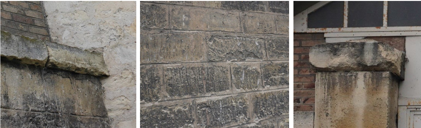
Pierres pulvérulentes ou desquamées. Jointoiement beurrant au ciment. Photos : Façade Est du bâtiment 12.
