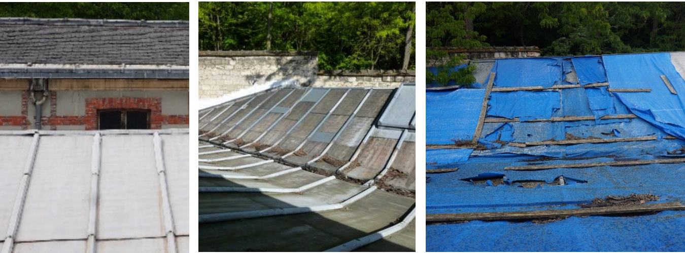
Couvre-joints désolidarisés. Rustines. Obstruction des chéneaux. Bâches en lambeaux. Photos : Versant Sud de l'aile centrale // Toiture du bâtiment 12.
