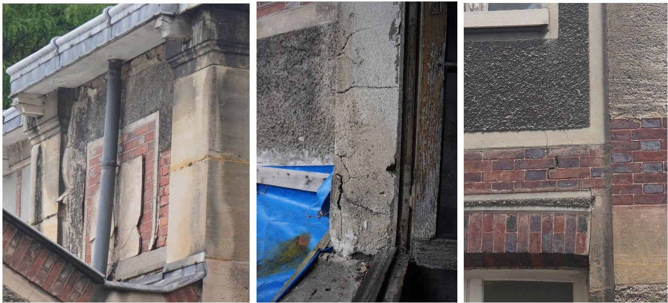
Déplatement et chutes des enduits. Faïençage et pulvérulence des enduits. Fissurations. Photos : Façade Sud de l'aile Nord // Façade Nord de l'aile Nord // Façade Est de l'aile Sud.
