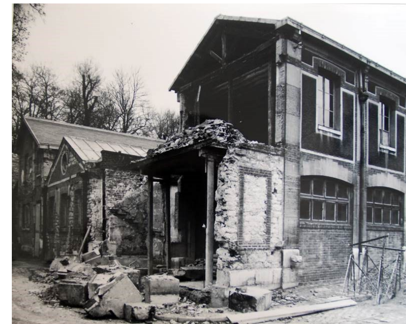
Photographies du bâtiment 13 suite aux bombardements de 1944. On remarque la charpente en bois traditionnelle de l'aile Sud.
