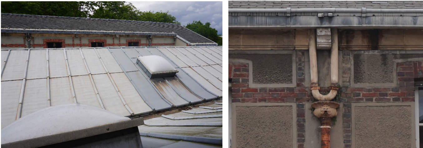
Vue de la façade Sud de l'aile Nord et de la couverture en zinc de l'aile centrale. Détail des naissances en plomb et boîte à eau à tête de lion - 2024
