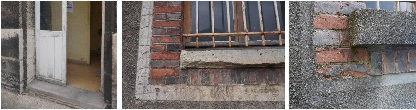
Seuil ragréé au ciment. Maçonneries pulvérulentes (briques et pierre). Disparition des joints rubans. Photos : Façade Est de l'aile Sud // Façade Est de l'aile Nord // Façade Ouest de l'aile centrale.
