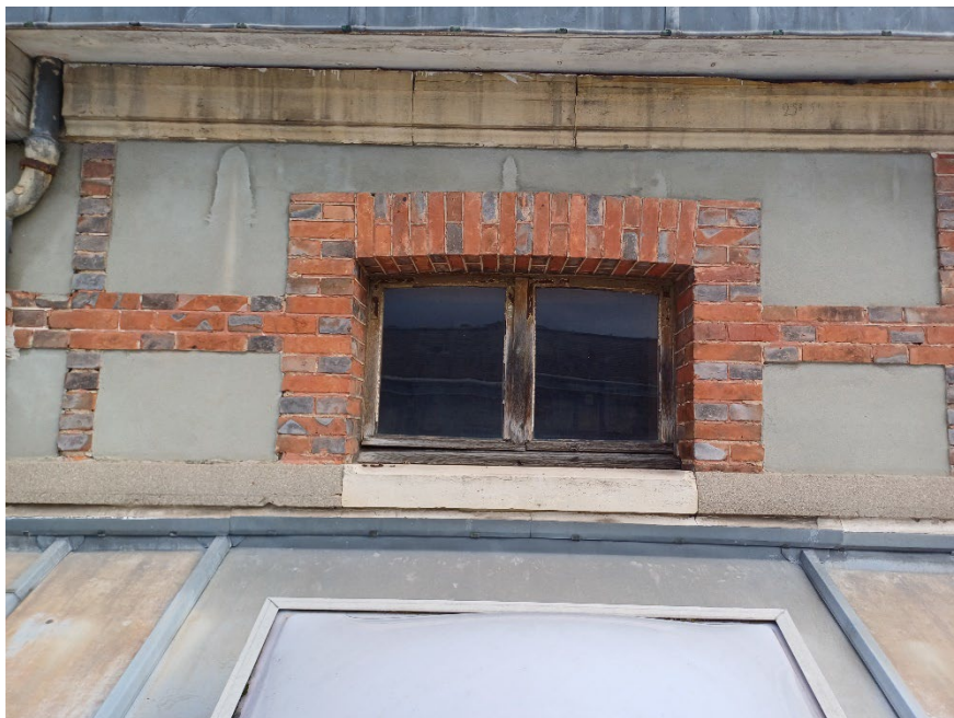
Détail d'un châssis des façades au-dessus des couvertures - 2024
