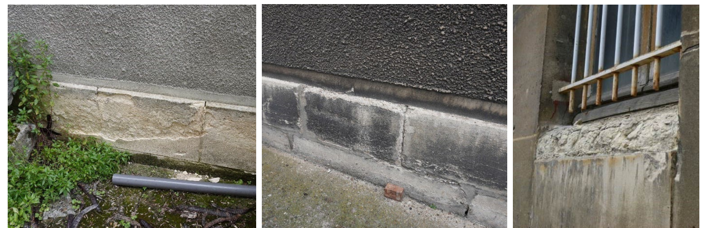
Pierres pulvérulentes, érosion du redent en soubassement. Disparition de matière. Jointoiment au ciment. Photos : Façade Ouest de l'aile Nord // Façade Est de l'aile Sud // Façade Est aile centrale.
