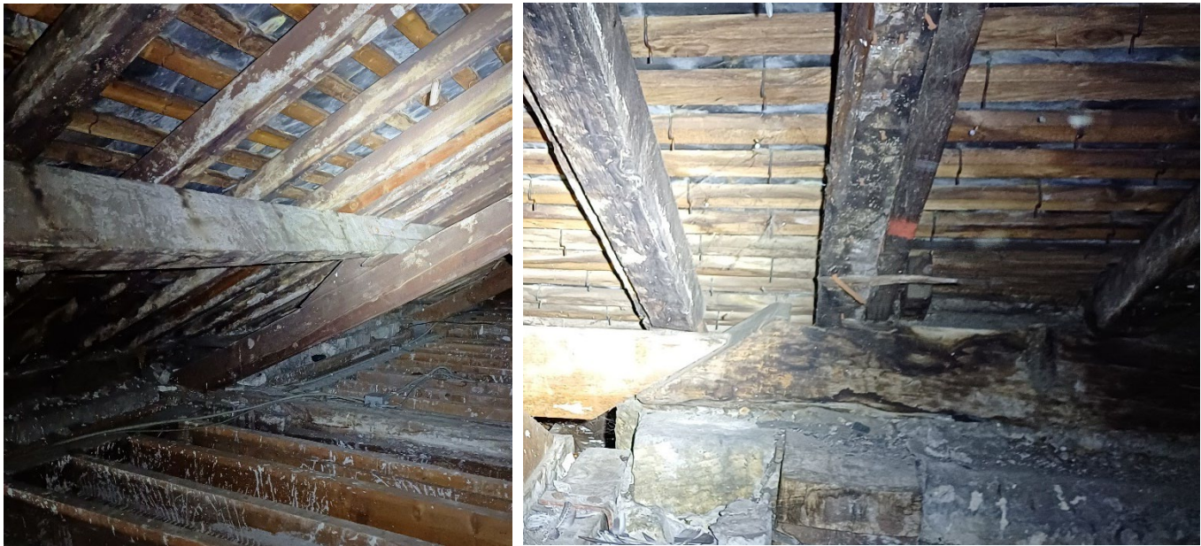
About de sablière et chevron pourris, développement de champignon, auréoles (infiltrations) sur le lattis. Photos : Charpente de l'aile Sud du bâtiment 13.
