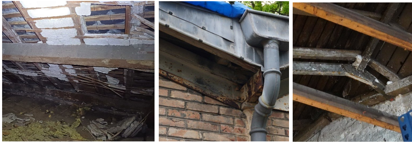
Lattis plâtre partiel et déplaqué. Oxydation de la charpente métallique. Photos : Charpente aile Sud du bât. 13 // Chéneau et arbalétrier de rive du bât. 12 // Charpente du bât. 12.
