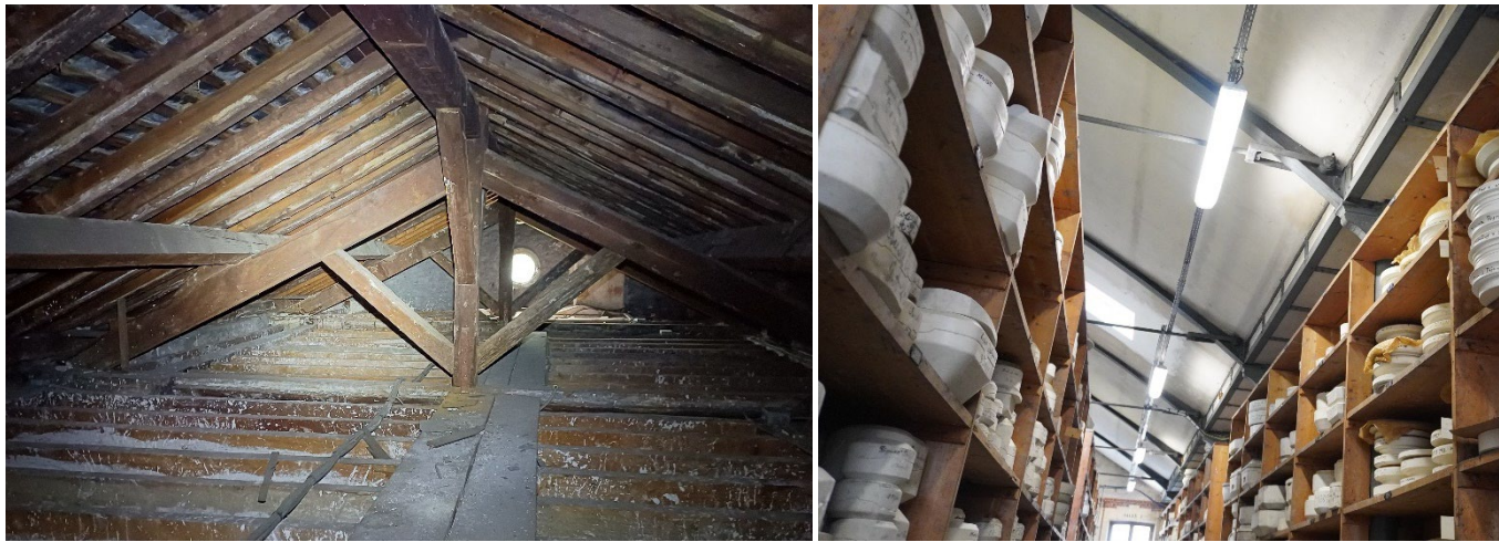
Vue de la charpente en bois de l'aile Sud. Vue de la charpente et de la structure métalliques du chéneau de l'aile centrale - 2024
