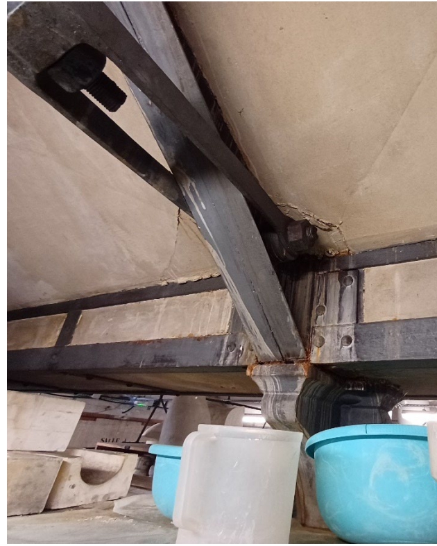
Détail d'un chéneau de l'aile centrale - 2024
