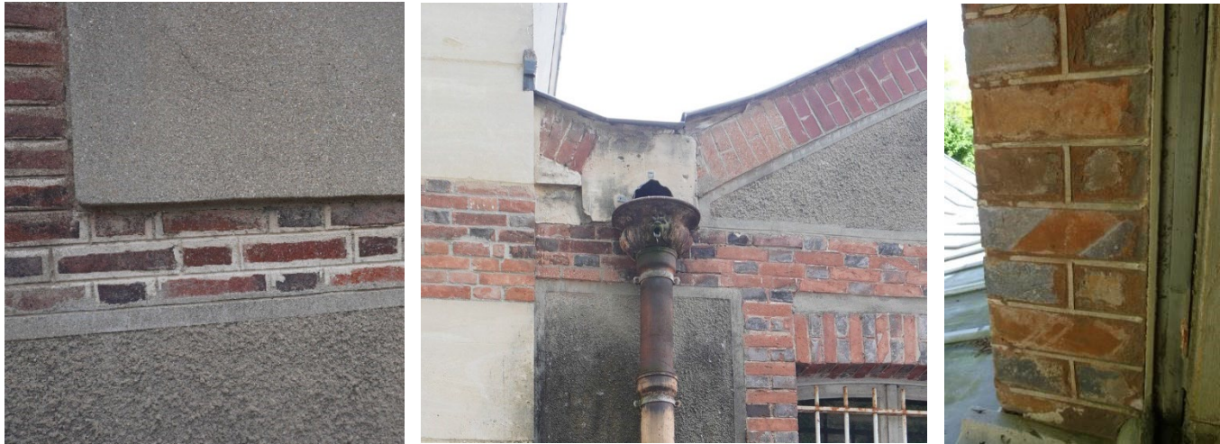
Jointoiement beurrant ciment. Ragréages ou briques modernes en remplacement des briques d'origine. Ragréages en périphérie des briques. Disparition des joints rubans. Photos : Façade Sud de l'aile Sud // Façade Ouest de l'aile centrale // Façade Nord de l'aile Nord.
