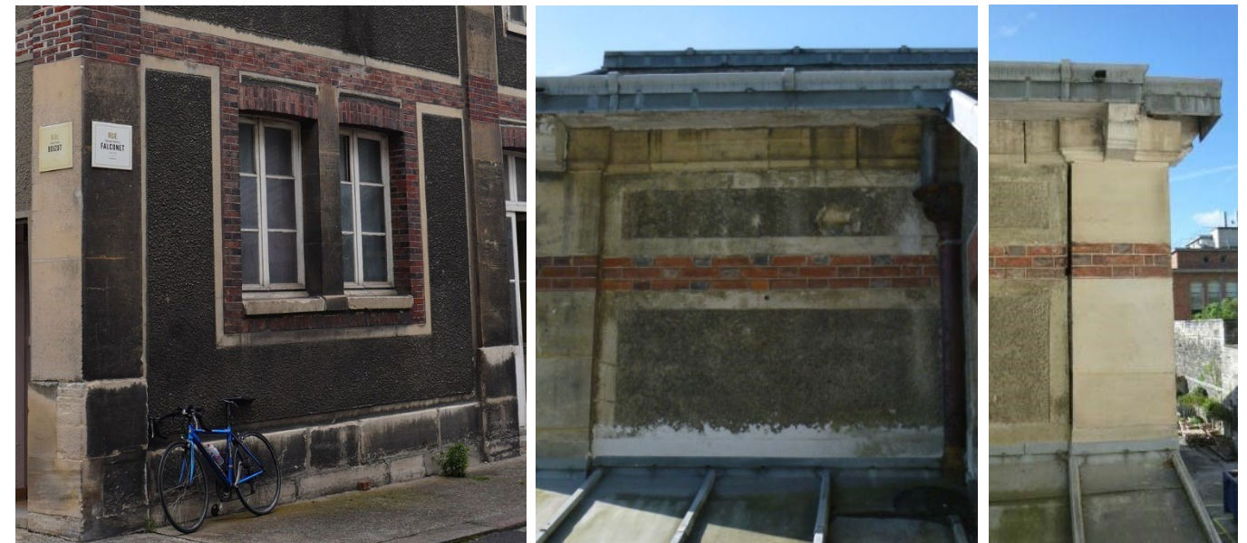
Encrassement des parements en pierre de taille et enduits. Solin grossier au plâtre. Fissure pilastre d'angle Photos : Façade Est de l'aile Sud // Façade Nord de l'aile Nord // Façade Nord de l'aile Nord.
